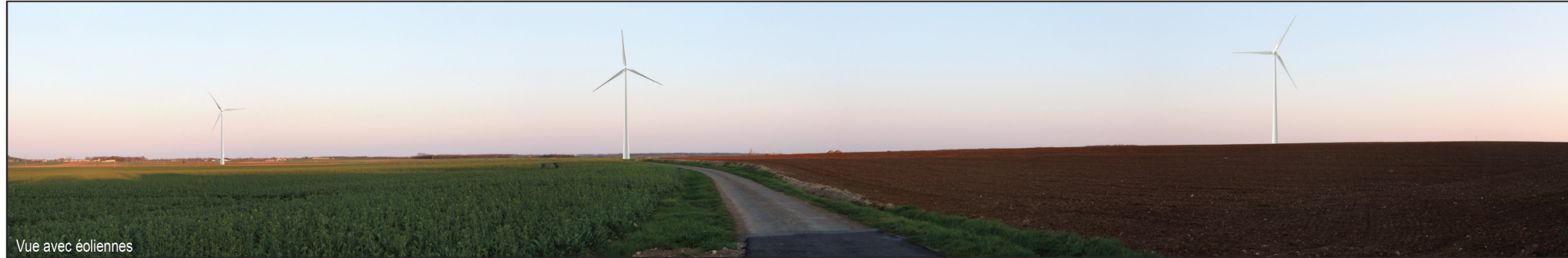
Vue en sortie du hameau de Launay – Distance à l'éolienne la plus proche : 800 m
